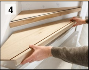
4 Monteer overzettreden en stootborden. Gebruik hiervoor een montagekit
